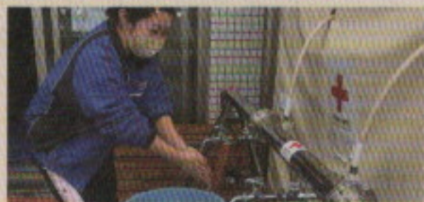
避難所に浄水・加温機器を設置
